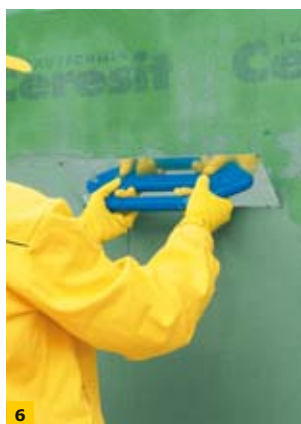
FOT. 5–7. Wtapianie siatki zbrojącej (zbrojenia): sposób nakładania siatki na zakładkę (FOT. 5), szpachlowanie łącza na gładko (FOT. 6), sposób klejenia siatki w strefie ościeża (FOT. 7); fot.: Henkel
