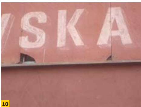
FOT. 10–11. Uszkodzenia mechaniczne płyt azbestowych osłaniających izolację z wełny mineralnej na szczytach budynku; fot. M. Krzyżanowski
