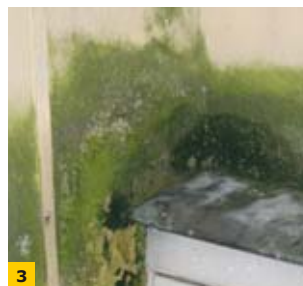
FOT. 1–3. Kolonie gronów i pleśni na ocieplonych ścianach budynków; fot.: archiwum autora
