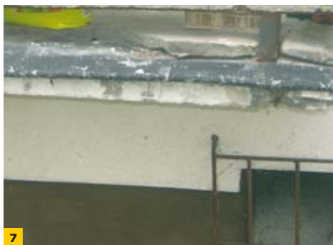
FOT. 7–8. Uszkodzenia balkonów; fot. M. Krzyżanowski
