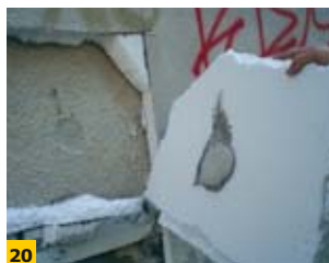
FOT. 14–20. Przykładowe czynności umożliwiające wykonanie oceny stanu istniejącego ocieplenia; fot.: archiwum autora
