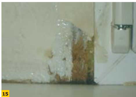
FOT. 14–15. Zawilgocenie na wewnętrznej powierzchni przegrody; fot. M. Krzyżanowski
