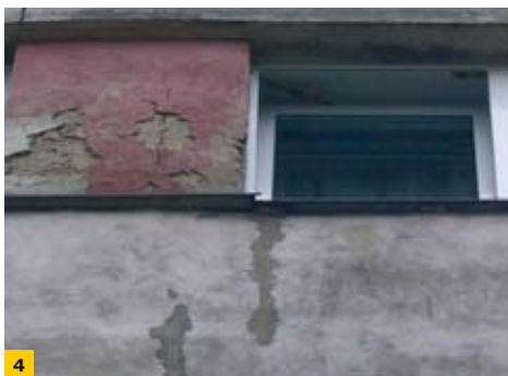
FOT. 4–5. Rysy i ubytki na ścianach w warstwie tynku zewnętrznego; fot. M. Krzyżanowski
