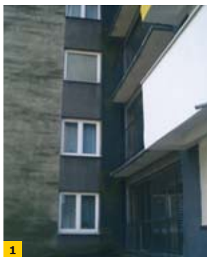
FOT. 1–3. Kolonie gronów i pleśni na ocieplonych ścianach budynków; fot.: archiwum autora
