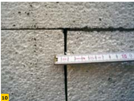
FOT. 10–11. Przykłady liniowych mostków termicznych; fot.: archiwum autora
