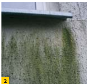
FOT. 1–3. Kolonie gronów i pleśni na ocieplonych ścianach budynków; fot.: archiwum autora
