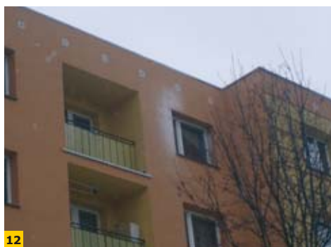
FOT. 12–13. Przykłady punktowych mostków termicznych; fot.: archiwum autora
