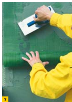
FOT. 5–7. Wtapianie siatki zbrojącej (zbrojenia): sposób nakładania siatki na zakładkę (FOT. 5), szpachlowanie łącza na gładko (FOT. 6), sposób klejenia siatki w strefie ościeża (FOT. 7); fot.: Henkel
