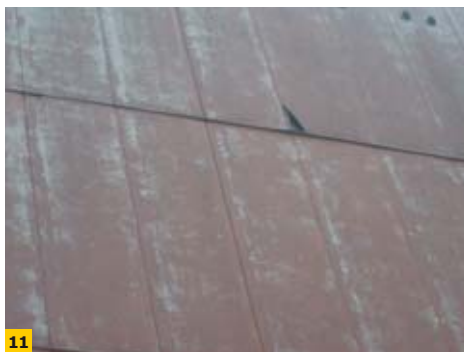
FOT. 10–11. Uszkodzenia mechaniczne płyt azbestowych osłaniających izolację z wełny mineralnej na szczytach budynku; fot. M. Krzyżanowski
