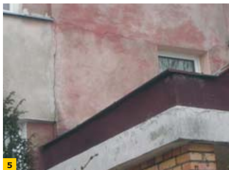
FOT. 4–5. Rysy i ubytki na ścianach w warstwie tynku zewnętrznego; fot. M. Krzyżanowski
