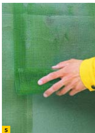
FOT. 5–7. Wtapianie siatki zbrojącej (zbrojenia): sposób nakładania siatki na zakładkę (FOT. 5), szpachlowanie łącza na gładko (FOT. 6), sposób klejenia siatki w strefie ościeża (FOT. 7); fot.: Henkel
