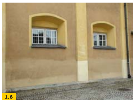
FOT. 1.3–1.6. Objaw podciągania kapilarnego – pas zawilgocenia o prawie stałej wysokości; fot.: archiwum autora
