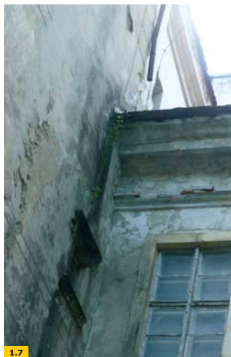
FOT. 1.7–1.9. Objawy oddziaływania wód opadowych; fot.: archiwum autora
