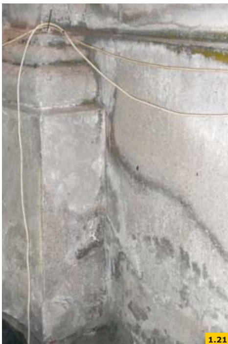
FOT. 1.21–1.23. Łączne oddziaływanie kilku rodzajów wilgoci (rozbryzgowej, wchłoniętej higroskopijnie i podciągania kapilarnego); fot.: archiwum autora
