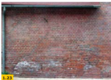
FOT. 1.21–1.23. Łączne oddziaływanie kilku rodzajów wilgoci (rozbryzgowej, wchłoniętej higroskopijnie i podciągania kapilarnego); fot.: archiwum autora
