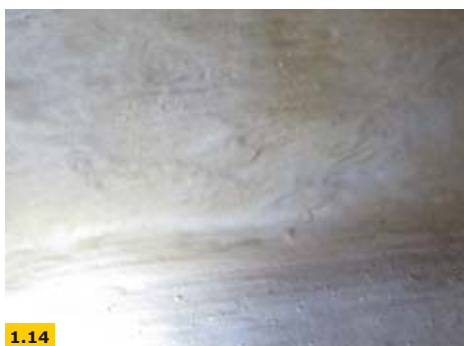
FOT. 1.10–1.14. Kondensacja wilgoci na powierzchni przegrody oraz hydroizolacji; fot.: archiwum autora
