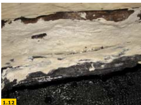
FOT. 1.10–1.14. Kondensacja wilgoci na powierzchni przegrody oraz hydroizolacji; fot.: archiwum autora
