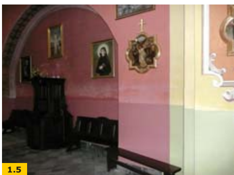
FOT. 1.3–1.6. Objaw podciągania kapilarnego – pas zawilgocenia o prawie stałej wysokości; fot.: archiwum autora
