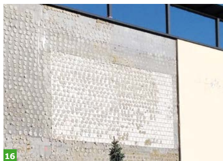
FOT. 16–17. Przyklejenie styropianu tylko na „placki”, bez pasma obwodowego jest bezpośrednim wskazaniem do demontażu ocieplenia. W razie pożaru płomień rozprzestrzenia się pod warstwą styropianu; fot.: autor
