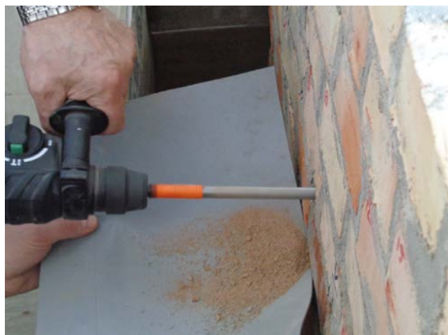
FOT. 2. Pobieranie zwiercin na potrzeby badania wilgotności muru przed wykonaniem iniekcji, fot.: autor
