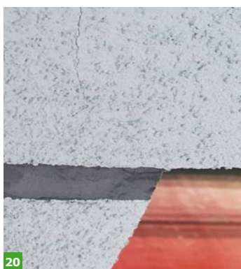
FOT. 20–21. Rysa w narożu. Jednak jej przyczyną jest nie tylko brak siatki diagonalnej, ale i nieprawidłowe wykonanie warstwy zbrojącej; fot.: autor
