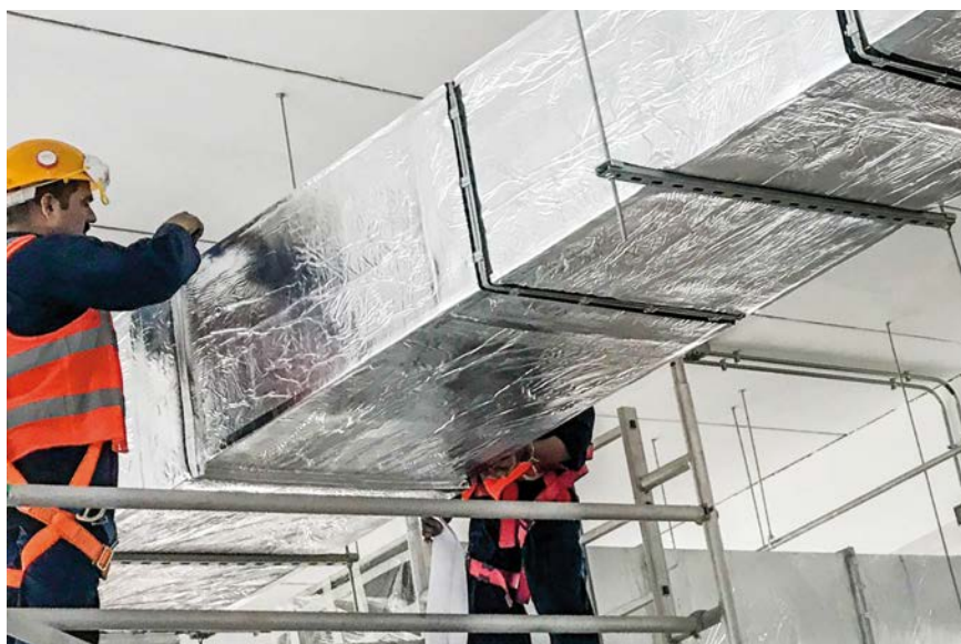
FOT. 2. Dodatkowa osłona z laminatu aluminiowego nadaje izolacji estetyczny wygląd i pozwala uzyskać łatwą do czyszczenia powierzchnię kanałów
