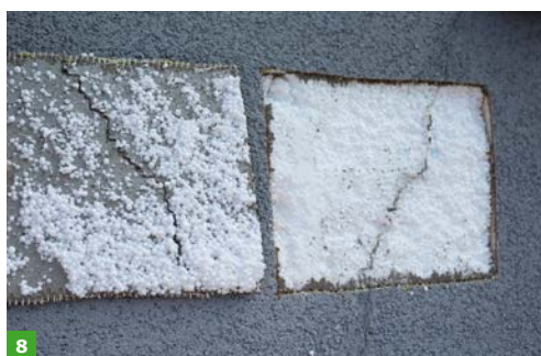
FOT. 7–9. Widok po wycięciu fragmentu warstwy zbrojącej i termoizolacji. Może on sugerować, że jedyną przyczyną powstania rysy jest brak siatek diagonalnych (por. RYS.); fot.: autor
