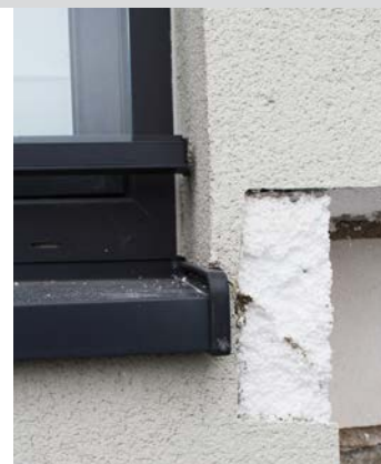
FOT. 6. Poszerzenie odkrywki. FOT. 2–5 pokazują błąd polegający na braku siatek diagonalnych (por. RYS.); fot.: autor
