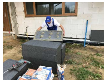
FOT. 4. Zaprawa klejąca Gabit Termo 1.6 służy do przyklejania płyt styropianowych (również grafitowych) do podłoża. Nanosi się ją na płyty metodą pasmowo-punktową
