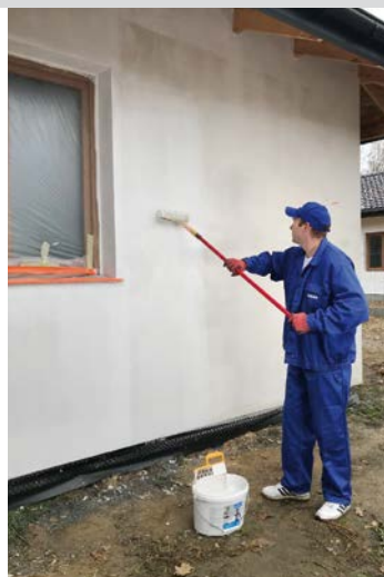
FOT. 7. Do tynkowania ścian można przystąpić po wyschnięciu warstwy gruntującej wykonanej przy użyciu preparatu SOLPLAST Plus 10.2
