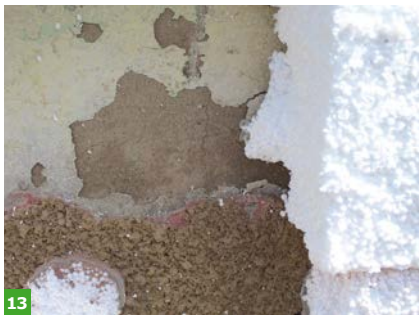
FOT. 13–14. Termoizolację przyklejono do starego, niestabilnego tynku; fot.: autor
