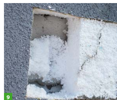
FOT. 7–9. Widok po wycięciu fragmentu warstwy zbrojącej i termoizolacji. Może on sugerować, że jedyną przyczyną powstania rysy jest brak siatek diagonalnych (por. RYS.); fot.: autor
