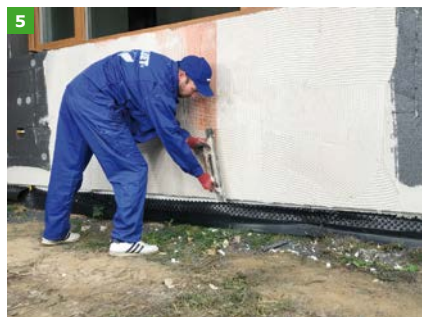
FOT. 5-6. Zaprawa Gabbit Termo Plus 1.4 stanowi wraz z siatką tynkarską z włókna szklanego stabilne podłoże na styropianie pod tynki o jasnej barwie
