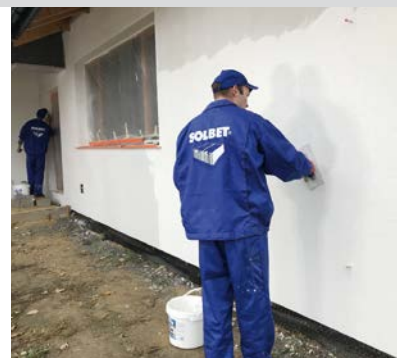
FOT. 8. Zadaniem tynku zewnętrznego jest ochrona ścian przed oddziaływaniem czynników atmosferycznych. Taki tynk powinien być również odporny na uszkodzenia mechaniczne, np. uderzenia, zatarcia itp. Tynki elewacyjne SOLBET pełnią również funkcję dekoracyjną
