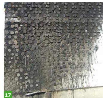
FOT. 16–17. Przyklejenie styropianu tylko na „placki”, bez pasma obwodowego jest bezpośrednim wskazaniem do demontażu ocieplenia. W razie pożaru płomień rozprzestrzenia się pod warstwą styropianu; fot.: autor
