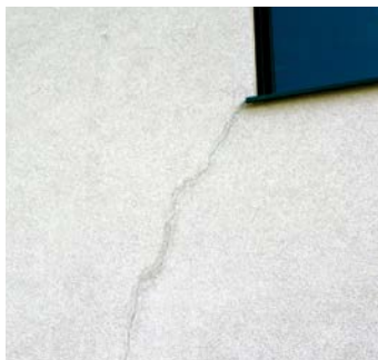
FOT. 1. Taki przebieg rysy może sugerować brak siatek diagonalnych, jednak nie zawsze tak musi być; fot.: autor
