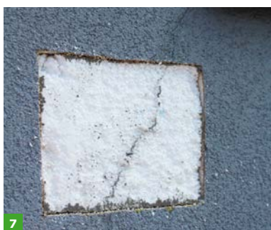
FOT. 7–9. Widok po wycięciu fragmentu warstwy zbrojącej i termoizolacji. Może on sugerować, że jedyną przyczyną powstania rysy jest brak siatek diagonalnych (por. RYS.); fot.: autor
