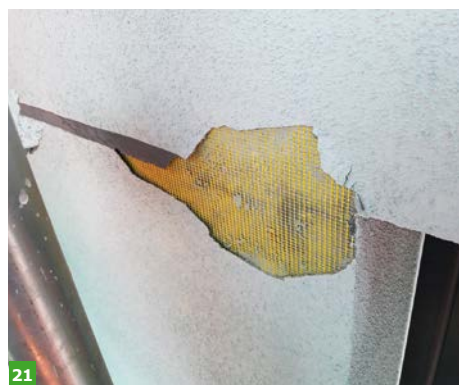
FOT. 20–21. Rysa w narożu. Jednak jej przyczyną jest nie tylko brak siatki diagonalnej, ale i nieprawidłowe wykonanie warstwy zbrojącej; fot.: autor
