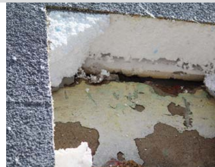
FOT. 15. Dodatkowo stwierdzono niejednorodne podłoże: poniżej rysy niestabilny (o niewystarczającej przyczepności) tynk, powyżej podklejki ze styropianu; fot.: autor
