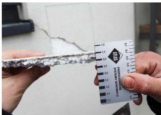
FOT. 5. Grubość i wygląd warstwy zbrojącej; fot.: autor
