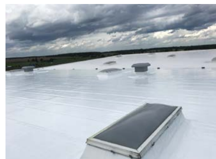
FOT. Przykład renowacji dachu z papy za pomocą membrany poliuretanowej Hyperdesmo
