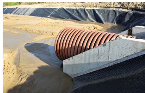
FOT. 1. Przykład montażu membrany za pomocą listwy aluminiowej na wpuście rurowym
