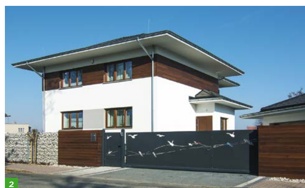
FOT. 1–2. Budynek jednorodzinny przed (1) i po (2) termomodernizacji
