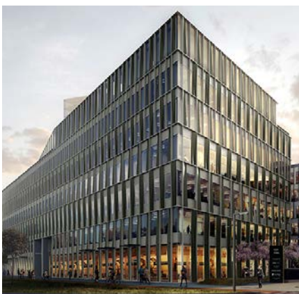
FOT. 3. Naturalnie występujące pasy międzykondygnacyjne w ścianach zewnętrznych o konstrukcji tradycyjnej; fot.: autor
