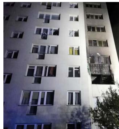
FOT. 2. Elewacja ocieplona systemem ETICS, który nie rozprzestrzenia ognia; fot.: autor
