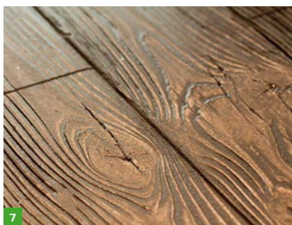
FOT. 5–8. Innowacyjne wyprawy zewnętrzne: efekt betonowej ściany wylewanej w szalunku (5), tynk dekoracyjny z dodatkiem płatków naturalnej miki (6), efekt drewna (deski) (7), efekt blachy (farby metaliczne) (8); fot.: Stowarzyszenie na Rzecz Systemów Ociepleń
