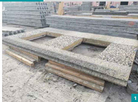
FOT. 1–3. Widok ogólny prefabrykatu zewnętrznej ściany trójwarstwowej oraz elementów łączących warstwę fakturową z konstrukcyjną; fot.: autor
