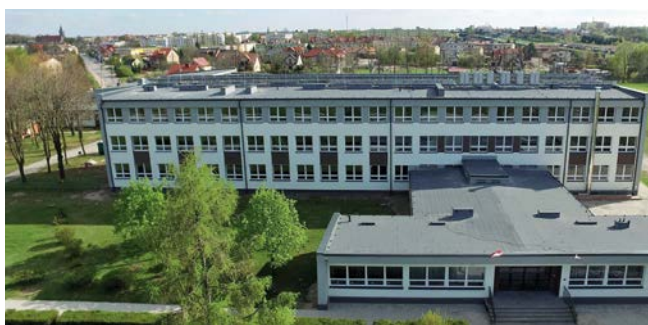
FOT. 2. Budynek szkoły w Końskich po przeprowadzonej termomodernizacji;
