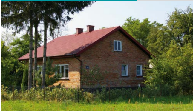
FOT. 3. Budynek jednorodzinny pod Siedlcami przed termomodernizacją; fot.: KAPE S.A.
