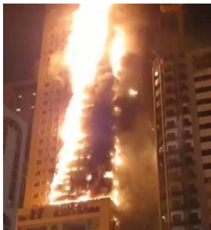
FOT. 1. Przykład rozprzestrzeniania ognia po elewacji w przypadku zastosowania okładzin rozprzestrzeniających ogień; fot.: www.lindaikiejisblog.com
