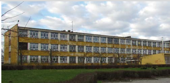
FOT. 1. Budynek szkoły w Końskich przed termomodernizacją;
