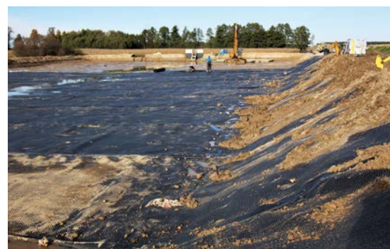
FOT. 2. Realizacja zbiornika o powierzchni 4800 m 2 – obiekt Obwodnica Kępna, droga ekspresowa S11
