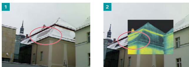
FOT. 1–2. Dach częściowo pokryty śniegiem nad poddaszem użytkowym budynku; fot.: autor
