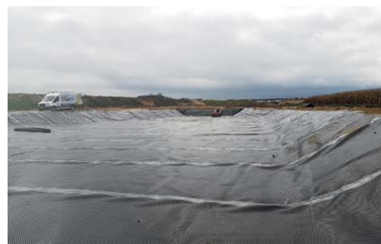
FOT. 3. Przykład z realizacji zbiornika. Widoczne boczne zgrzewy membrany
