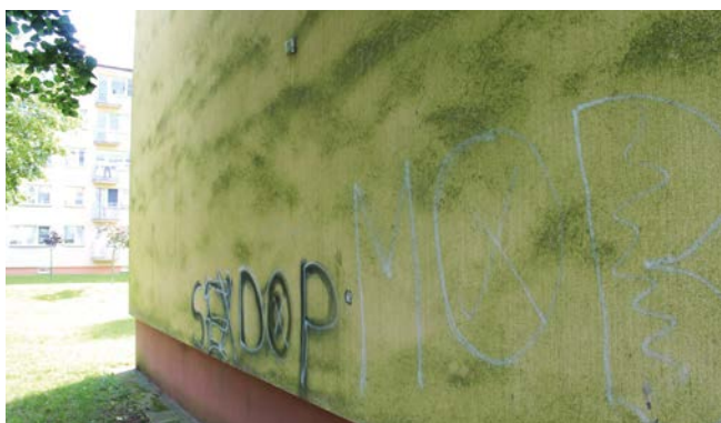
FOT. 1. Rozwój glonów na powierzchni tynku; fot.: autorzy
