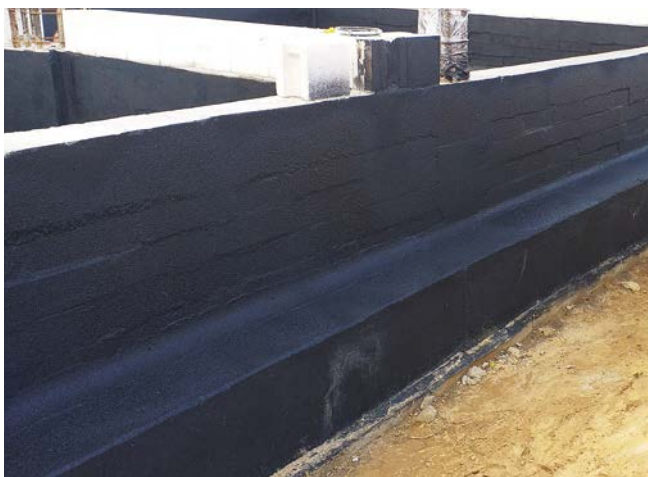
FOT. 2. Izolacja fundamentu – Nexler BITFLEX 1KP
