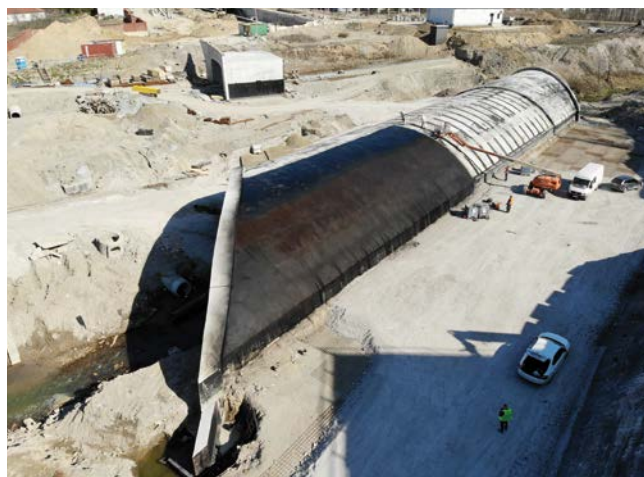
FOT. 3. Izolacja przepustu – Nexler BITFLEX Quick Spray
