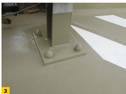
FOT. 1–4. Uszczelnienia detali przylegających do posadzek parkingowych z powłoki polimocznikowej MasterSeal M 689
