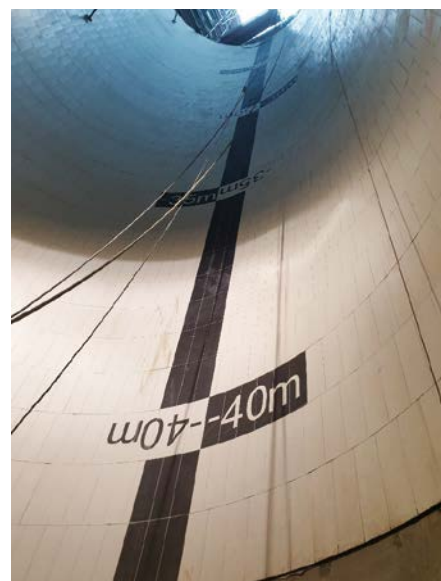
FOT. 1. Tuba basenu podczas aplikacji okładziny ceramicznej na głębokości 40 m
