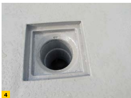
FOT. 1–4. Uszczelnienia detali przylegających do posadzek parkingowych z powłoki polimocznikowej MasterSeal M 689
