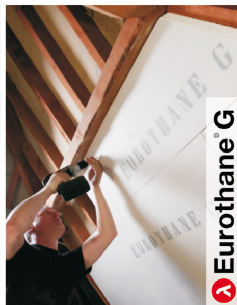
Izolacja podkrokwiova
