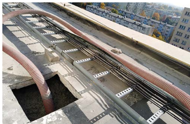
FOT. 4. Ocieplanie stropodachów wentylowanych; fot.: materiały firmy Derowerk Zbigniew Biały
