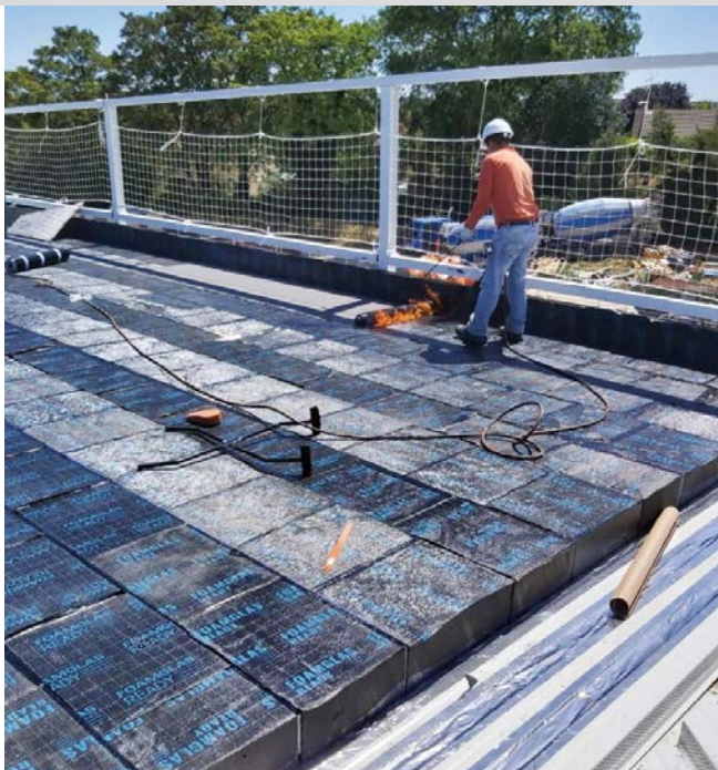
FOT. Montaż płyt izolacyjnych ze spienionego szkła komórkowego FOAMGLAS®
