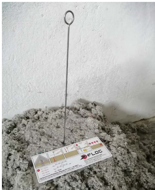
FOT. 1. Pomiar grubości izolacji z użyciem płytki pomiarowej; fot.: autor
