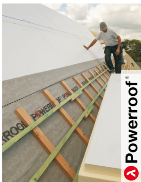
Izolacja nakrokwiova
