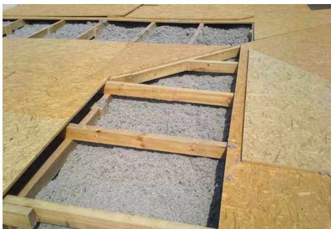
FOT. 2. Ocieplenie stropu celulozą; fot.: autor
