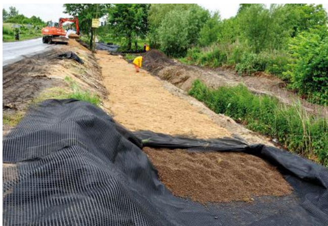
FOT. 5. Przykrycie wypełnienia i pierwsza warstwa podbudowy
