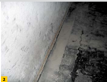
FOT. 1–2. Błędne wykonanie izolacji poziomej – pas papy wystaje poza lico ściany o 1–2 cm (powinien wystawać min. o 6 cm); fot.: autor
