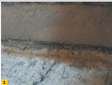
FOT. 1–2. Błędne wykonanie izolacji poziomej – pas papy wystaje poza lico ściany o 1–2 cm (powinien wystawać min. o 6 cm); fot.: autor
