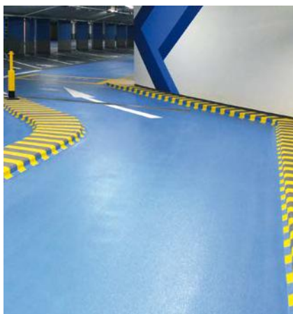
FOT. 2. Nawierzchnia parkingu wykonana z żywicy PMMA
