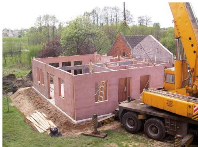
FOT. 8. Przykładowe zastosowanie prefabrykatów z keramzytu do budowy domów jednorodzinnych; fot.: Leca
