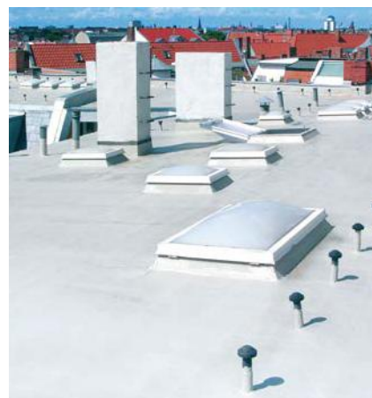
FOT. 3. Uszczelnienie dachu żywicami PMMA
