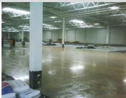
FOT. 1. Powierzchnia posadzki w trakcie realizacji (w trakcie układania betonu) (przykład – hala nr 3);
