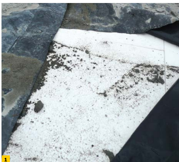
FOT. 1–2. Taras wykonany według schematu pokazanego na RYS. 4, widok po usunięciu jastrychu dociskowego; fot.: autor
