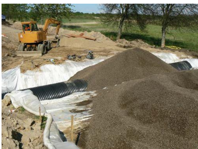
FOT. 5. Lekkie wypełnienie nad przepustem na gruntach słabonośnych; fot.: Leca
