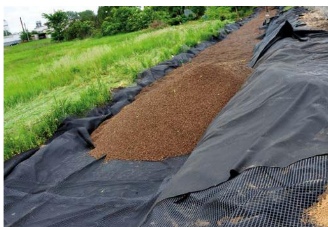
FOT. 4. Lekkie wypełnienie z keramzytu w geotkaninie
