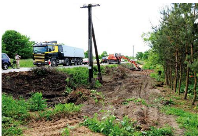
FOT. 1. Wykopy pod ścieżkę
