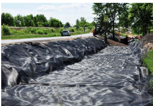
FOT. 3. Ułożenie geotkaniny z zapasem do przykrycia
