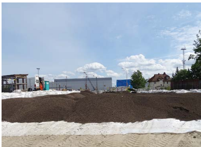
FOT. 4. Budowa nasypu z zastosowaniem keramzytu; fot.: Mars Most Brdowski
