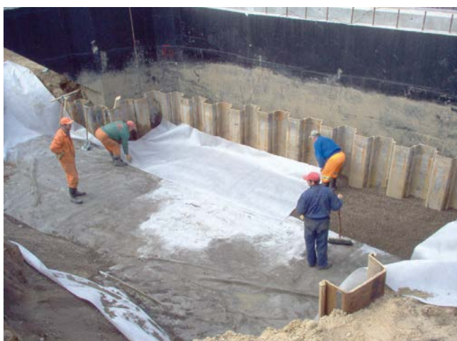
FOT. 6. Zabudowa przyczółka mostowego z zastosowaniem kruszyw lekkich; fot.: Leca
