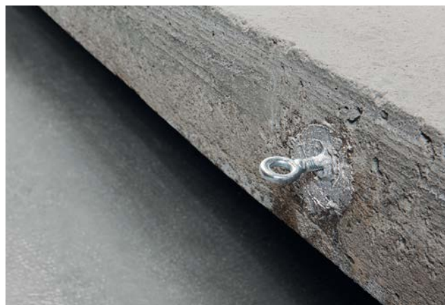
FOT. 1. Zastosowana w praktyce kotwa chemiczna; fot.: Torggler
