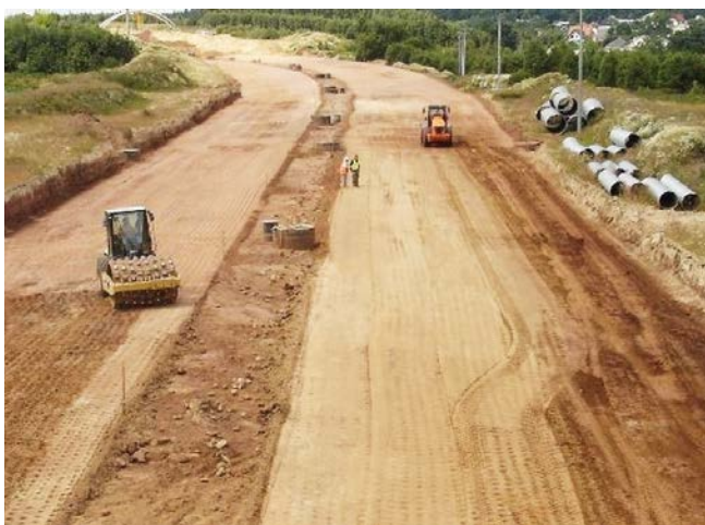
FOT. 7. Zastosowanie kruszywa lekkiego do odciążenia warstwy podłoża; fot.: Certyd
