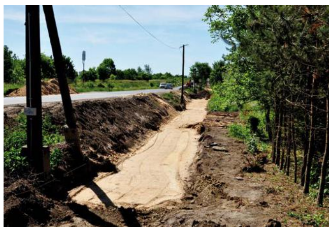
FOT. 2. Wyrównanie podłoża w wykopie
