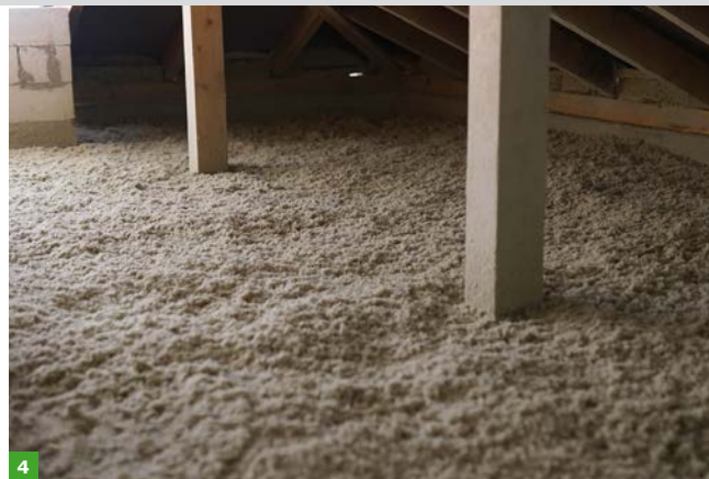
FOT. 3–4. Przykład gotowego ocieplenia. Izolacja z włókien celulozowych (3) oraz granulát z wełny mineralnej (4); fot.: Derowerk (3), Rockwool (4)
