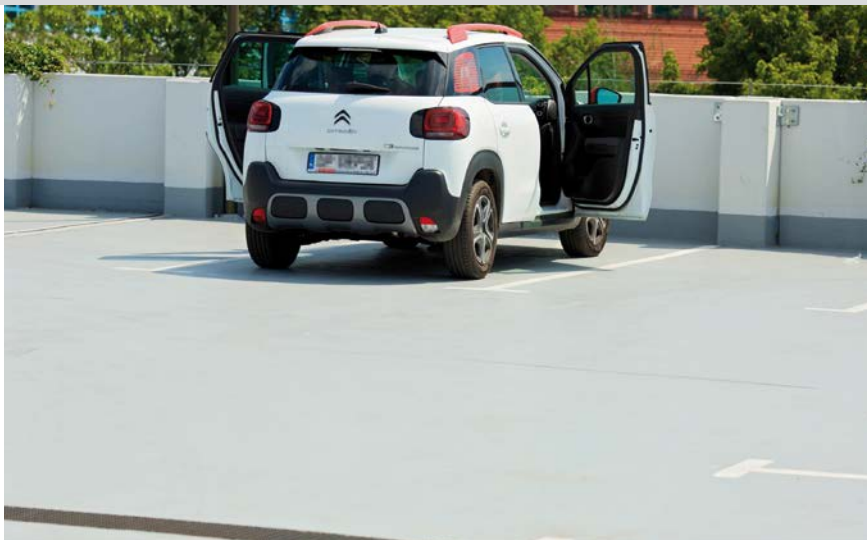
FOT. 2. Nawierzchnio-izolacja polimocznikowa na parkingu wielopoziomowym w Rybniku przy ul. Hallera; fot.: Jerzy Kieroński Biuro Usługowo-Handlowe KJ Kędzierzyn-Koźle – wykonawca
