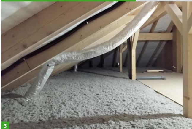
FOT. 3–4. Przykład gotowego ocieplenia. Izolacja z włókien celulozowych (3) oraz granulát z wełny mineralnej (4); fot.: Derowerk (3), Rockwool (4)
