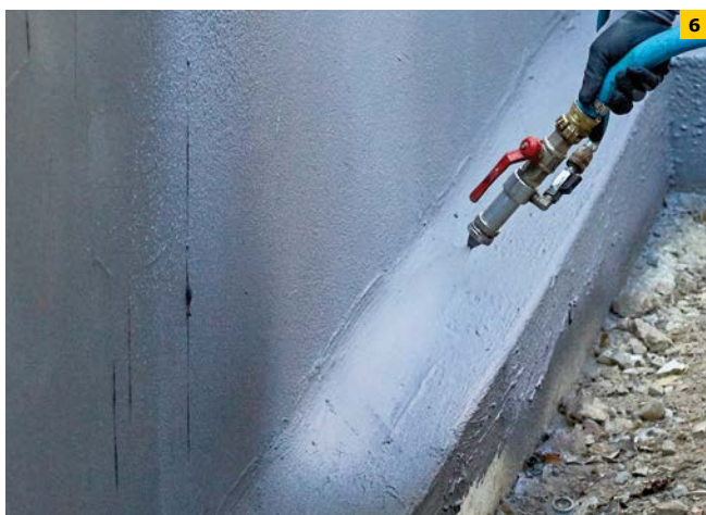
FOT. 4-6. Wszystkie zaprawy mogą być nakładane na podłoże różnymi technikami: za pomocą pędzla (4), pacy (5) oraz odpowiedniego urządzenia natryskowego (6)
