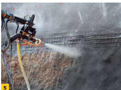
FOT. 2–7. Zastosowanie fibrobetonu z włóknami polimerowymi; fot.: [55–59]
