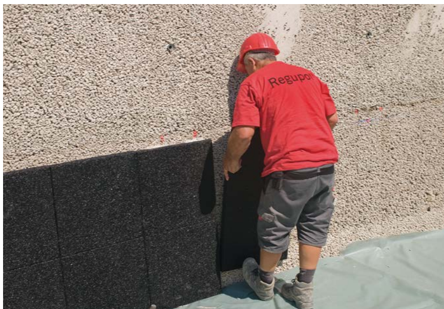
FOT. 1. Montaż wibroizolacji pionowej Regupol Vibration 450
