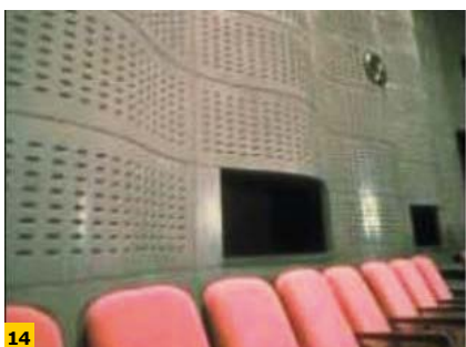
FOT. 11–16. Zastosowanie fibrobetonu z włóknami szklanymi; fot.: [71–76]
