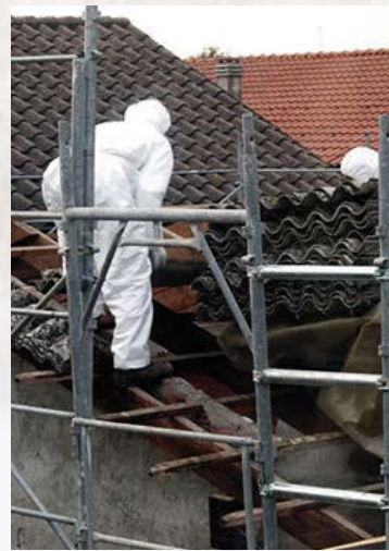
USUWANIE AZBESTU
