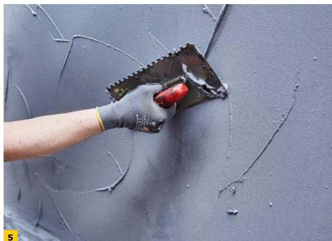
FOT. 4-6. Wszystkie zaprawy mogą być nakładane na podłoże różnymi technikami: za pomocą pędzla (4), pacy (5) oraz odpowiedniego urządzenia natryskowego (6)
