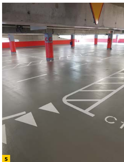
FOT. 4-5. Powłoka polimocznikowa na parkingu „Parkuj i jedź” przy ul. Kasprzycza 145, w Warszawie; fot.: Stanisław Świtalski StanEpoxyd – wykonawca
