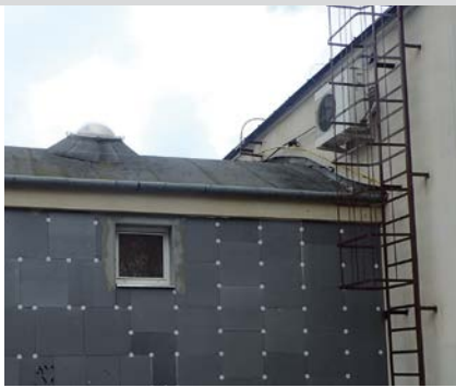
FOT. 1. Ściana budynku herpetarium przed otynkowaniem z widocznymi panelami próżniowymi VIP
