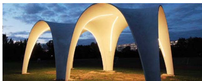
FOT. 18. Pawilon wykonany z betonu zbrojonego włóknami węglowymi w Niemczech; fot.: [78]
