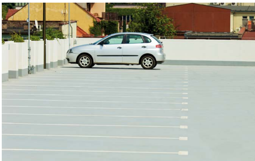
FOT. 1. Nawierzchnio-izolacja polimocznikowa na parkingu wielopiętrowym w Rybniku przy ul. Hallera; fot.: Jerzy Kieroński Biuro Usługowo-Handlowe KJ Kędzierzyn-Koźle – wykonawca
