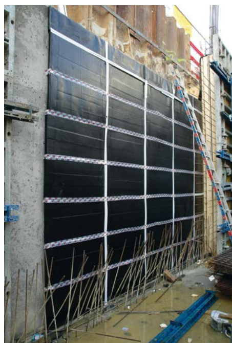
FOT. 2. Wibroizolacja ściany fundamentowej – dylatacja
