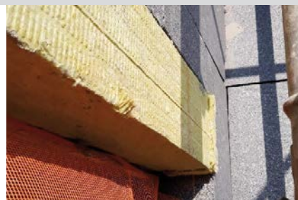
FOT. 7. Widok nadproża komory spalania w trakcie montażu ocieplenia; fot.: autorzy
