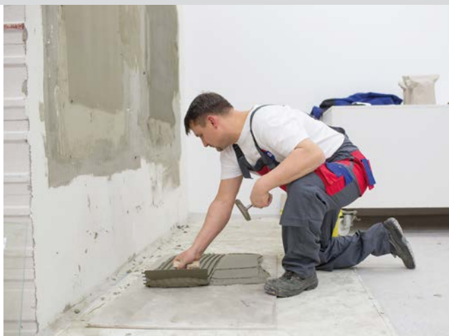
FOT. 3. Kleje żelowe są bardzo wygodne dla wykonawcy, a dzięki akumulacji przez żel krzemianowy wody potrzebnej do pełnej hydratacji cementu, zapewniają także korzystniejsze parametry techniczne, przede wszystkim przyczepność i trwałość; fot.: Atlas
