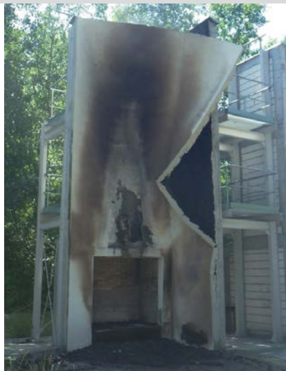
FOT. 10. Widok ściany EPS z nadprożem z wełny mineralnej po badaniu; fot.: autorzy
