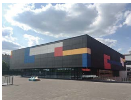
FOT. 1. Przykład elewacji z wykorzystaniem płyt włóknisto-cementowych; fot.: [2]
