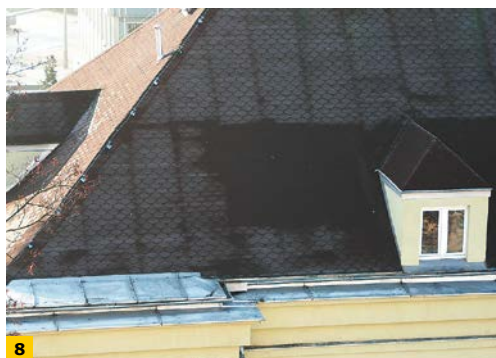
FOT. 8-9. Ten dach również jest pokryty dachówką bitumiczną, lecz straty ciepła są w nim na pewno większe niż w tym pokazanym na FOT. 7 . W związku z tym można śmiało stwierdzić, że termoizolacja tego dachu jest nieskuteczna, bo jest mokra, lub (i) jest jej za mało; fot.: K. Lenart
