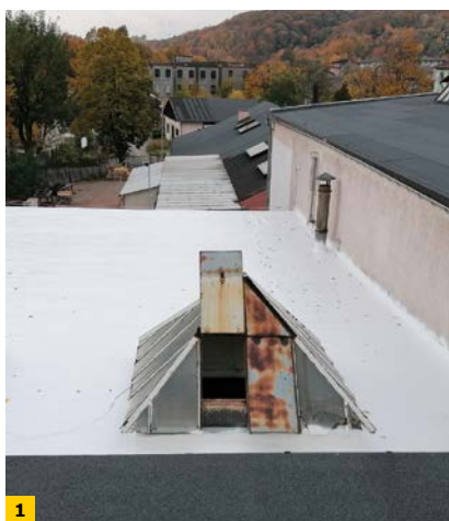
FOT. 1–2. Efekt na dachu ze świetlikami i kominami, aplikacja PWP 100 na papę
