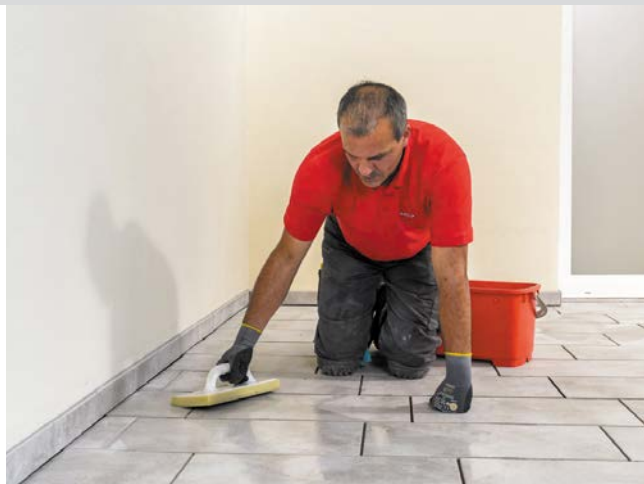
FOT. 2. Według obecnych standardów dąży się do maksymalnego zmniejszenia szerokości spoin albo wręcz całkowitej rezygnacji z pozostawienia przerw pomiędzy sąsiadującymi płytkami. Podyktowane jest to względami estetycznymi, a także modą na stosowanie płytek ceramicznych o dużych i bardzo dużych formatach; fot.: Sopro
