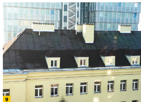
FOT. 8-9. Ten dach również jest pokryty dachówką bitumiczną, lecz straty ciepła są w nim na pewno większe niż w tym pokazanym na FOT. 7 . W związku z tym można śmiało stwierdzić, że termoizolacja tego dachu jest nieskuteczna, bo jest mokra, lub (i) jest jej za mało; fot.: K. Lenart
