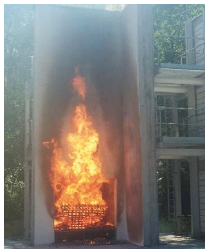
FOT. 9. Ściana EPS z nadprożem w trakcie badania; fot.: autorzy
