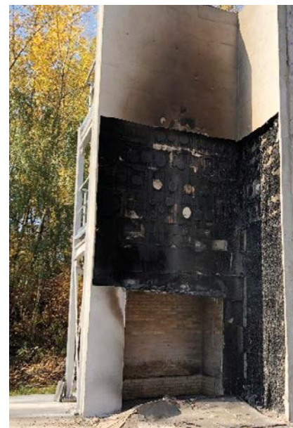
FOT. 6. Ściana EPS po usunięciu warstwy zbrojonej; fot.: autorzy
