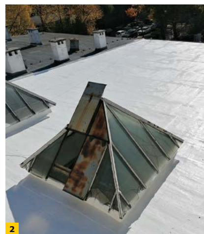
FOT. 1–2. Efekt na dachu ze świetlikami i kominami, aplikacja PWP 100 na papę
