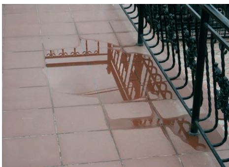
FOT. 17. Spadek potłaci powinien umożliwić odprowadzenie wody opadowej poza obręb tarasu; fol.: autor
