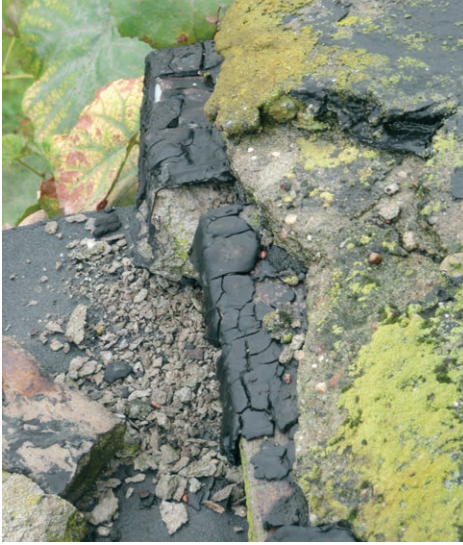
FOT. 18. Izolacja międzywarstwowa tarasu wykonana z tradycyjnego lepiku po kilku latach eksploatacji; fot.: autor
