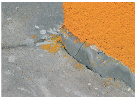
FOT. 12. Takie wykonanie dylatacji brzegowej przy izolacji międzywarstwowej z membrany dachowej uniemożliwia poprawne wykonanie warstwy użytkowej. Konieczne jest usunięcie wszystkich warstw aż do płyty nośnej i wykonanie ich w poprawny sposób; fol.: autor
