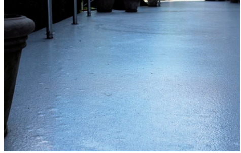
FOT. 21. Pęcherze osmotyczne na połąci tarasu nad pomieszczeniem z wykończeniem żywicą reaktywną; fot.: autor
