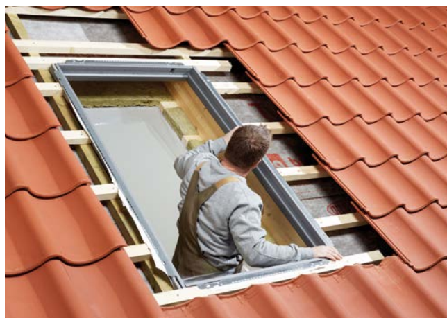
FOT. 4. Zestaw wokółfokiennej izolacji termicznej BDX gwarantuje łatwy i szybki montaż, a dodatkowo daje pewność, że wszystkie miejsca styku okna z dachem zostaną właściwie ocieplone i zaizolowane. Przy jego zastosowaniu można przedłużyć gwarancję na okna do 20 lat
