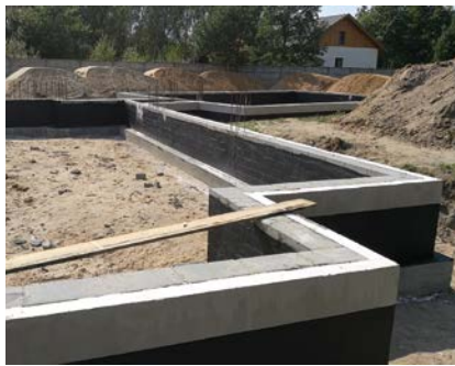
FOT. 2. Ocieplone ściany fundamentowe; fot.: autor
