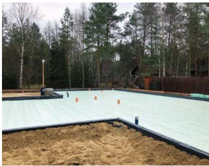
FOT. 1. Ocieplenie płyty fundamentowej; fot.: autor
