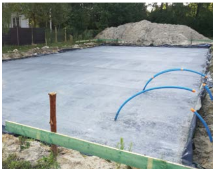
FOT. 4. Podbudowa pod płytę fundamentową z pianobetonu; fot.: autor
