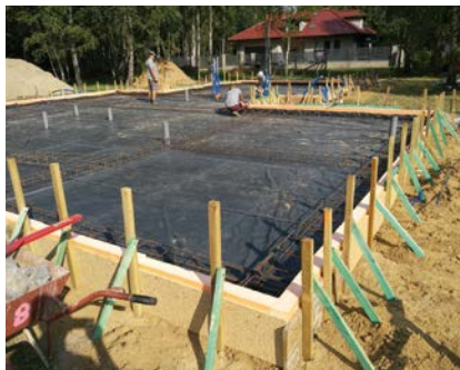
FOT. 5. Przygotowane ocieplenie płyty fundamentowej z płyt XPS; fot.: autor
