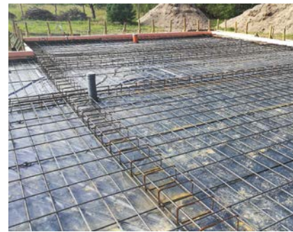
FOT. 3. Płyta fundamentowa przed zalaniem; fot.: autor
