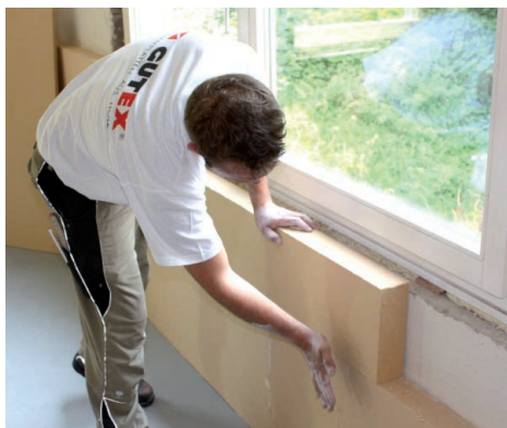
FOT. 4. Zastosowanie wełny drzewnej od wewnątrz; fot.: Gutex
