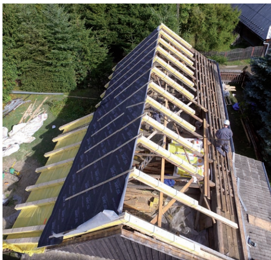
FOT. 1. Renowacja całej połaci dachowej
