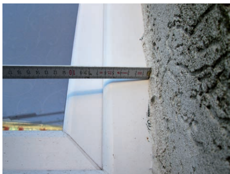
FOT. 21. Określenie szerokości ramy okiennej pod kątem możliwości ocieplenia ościeża; fot. archiwum autora
