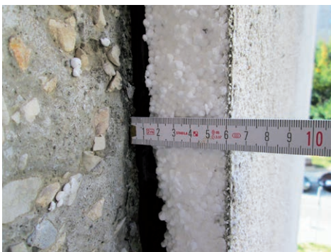
FOT. 9. Pomiar grubości odsunięcia termoizolacji od podłoża; fot. archiwum autora
