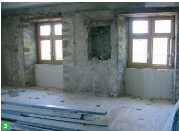
FOT. 1–2. Zastosowanie izolacji z aerozolu w miejscu pocienienia ściany zewnętrznej; fot.: EnergieCluster [8]
