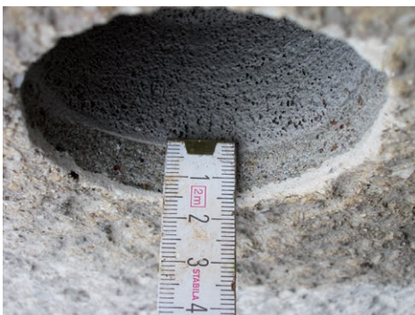
FOT. 11. Pomiar grubości warstwy nienośnych ściany – tynk zewnętrzny; fot. archiwum autora
