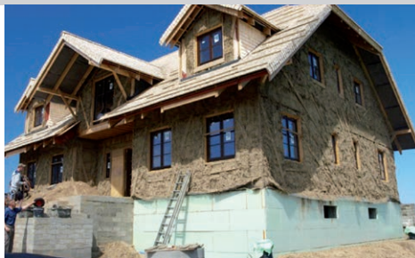
FOT. 2. Przykład ekologicznego systemowego rozwiązania materiałowego – technologia strawbale; fot.: www.budownictwonaturalne.info.pl
