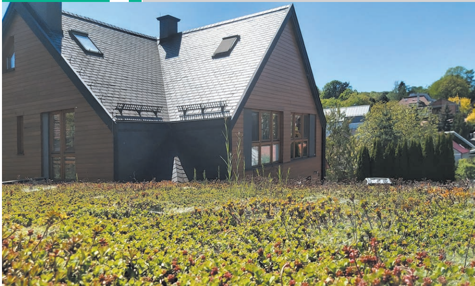
FOT. 4. Dachy zielone są często stosowane na garażach, przy domach prywatnych; fot.: Piotr Wolański APK Dachy Zielone
