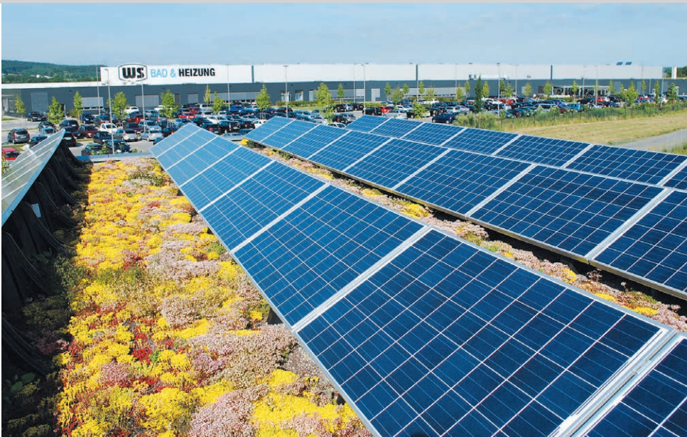
FOT. 1. Fotowoltaika na zielonym dachu z roślinnością w uprawie ekstensywnej; fot.: Optigruen International AG
