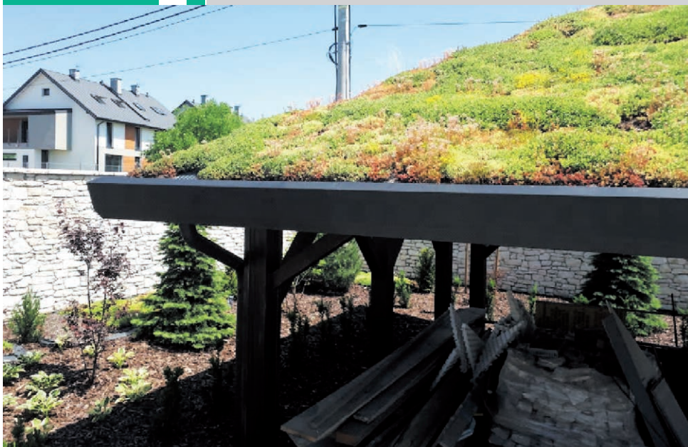
FOT. 2. Dach na wiacie przy domu prywatnym w okolicach Krakowa zarośnięty różnymi gatunkami rozchodników; fot.: Katarzyna Wolańska
