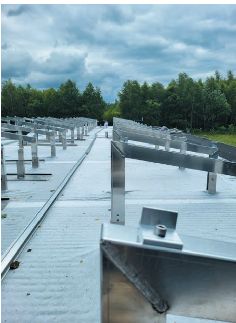
FOT. 3. Dach biosolarny w trakcie montażu;
