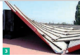
FOT. 1–3. Przykłady uszkodzeń pokryć dachowych, związane z niewłaściwym mocowaniem ich do podłoża: pokrycie papowe (1), membrana PVC (2), pokrycie z blachy (falistej, powlekananej) (3); fot.: [1]
