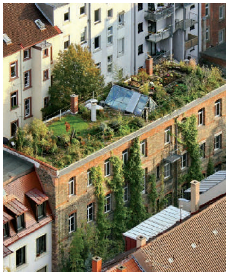
FOT. Biotyczny dach i ściany w zabudowie miejskiej Karlsruhe; fot.: Fränkle; http://presse.karlsruhe.de [4]
