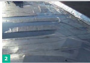
FOT. 1–3. Przykłady uszkodzeń pokryć dachowych, związane z niewłaściwym mocowaniem ich do podłoża: pokrycie papowe (1), membrana PVC (2), pokrycie z blachy (falistej, powlekananej) (3); fot.: [1]
