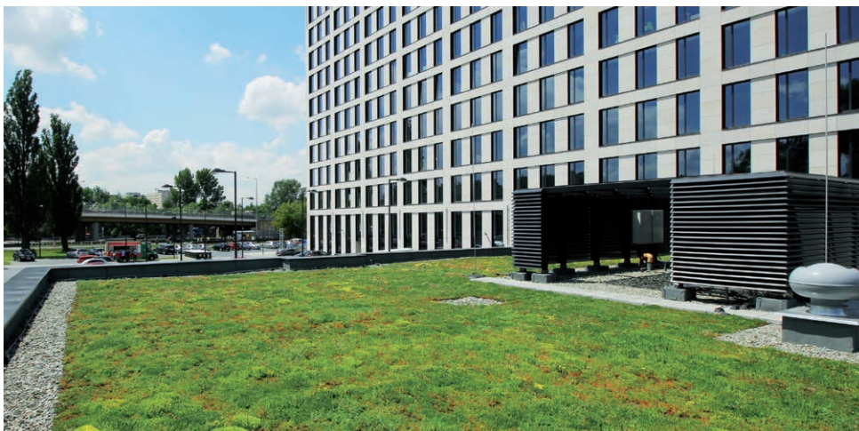
FOT. 1. Dach zielony w uprawie ekstensywnej, biurowiec w Krakowie, fot.: APK Dachy Zielone
