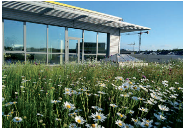
FOT. 2. Łąka kwietna o powierzchni ok. 800 m 2 na dachu budynku biurowego w Krakowie; fot.: APK Dachy Zielone
