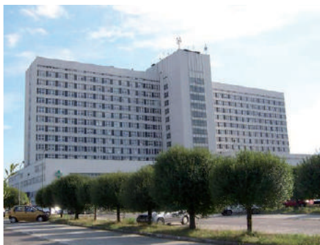
FOT. 1. Widok modernizowanego budynku;
