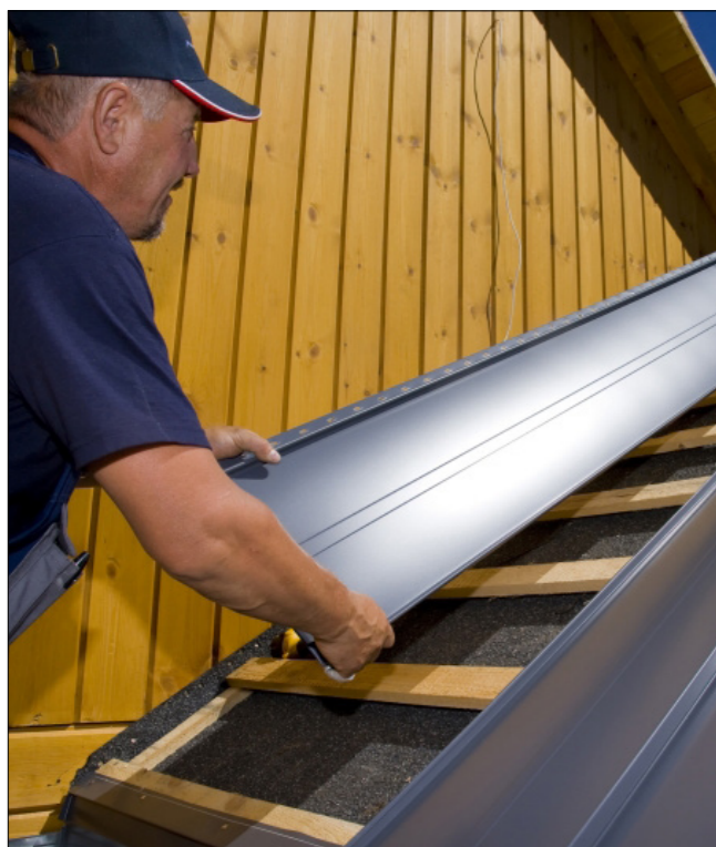
Układanie blachy na rąbek stojący
