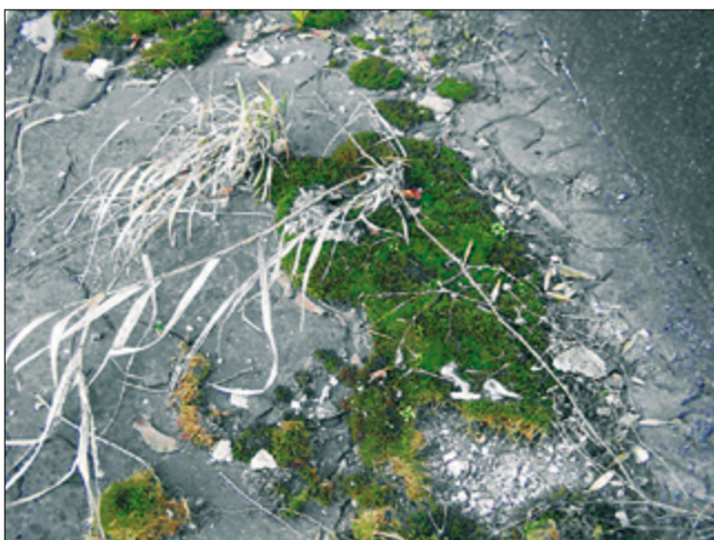
Fot. 1. Zniszczone pokrycie dachu płaskiego. Podwyższona temperatura oraz narażenie na oddziaływanie promieniowania UV i korozję biologiczną powodują znaczne skrócenie okresu trwałości pokrycia w stropodachach pełnych Fot. archiwum autora
