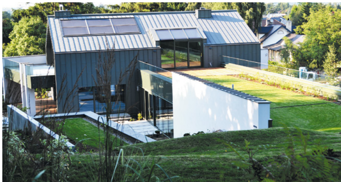
Dach zielony na rezydencji prywatnej
