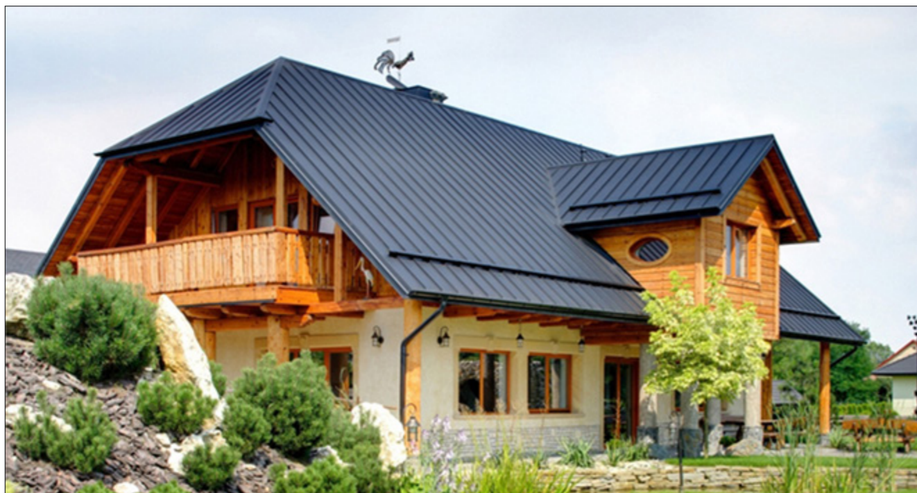
Dach pokryty blachą na rąbek stojący
