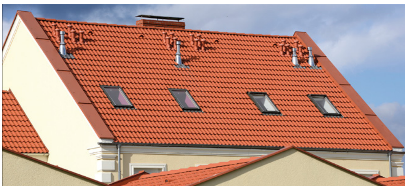
Dach pokryty dachówką cementową
