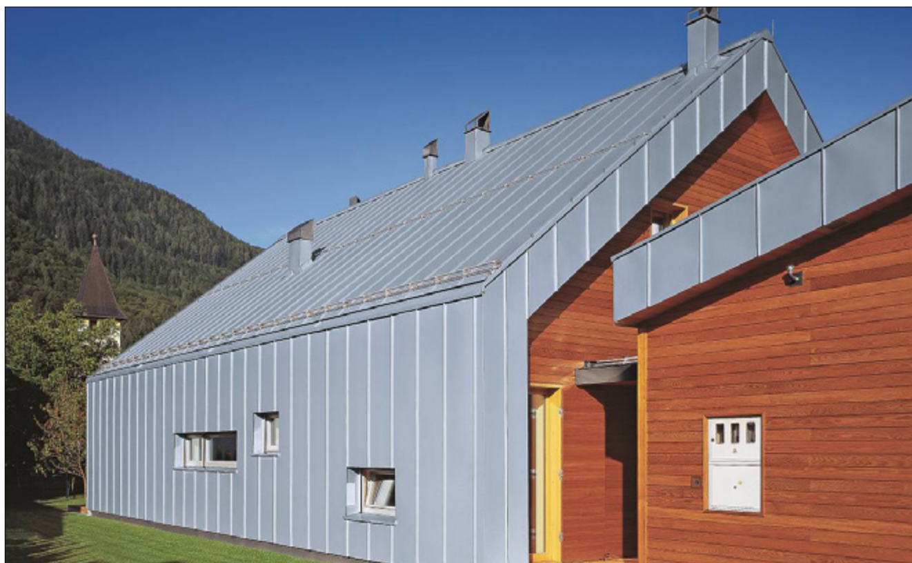
Pokrycie z blachy cynkowo-tytanowej
