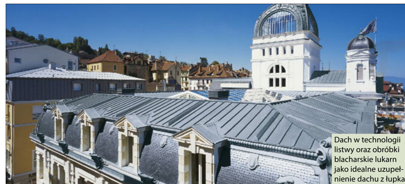
Dach ułożony na rąbek kątowy
