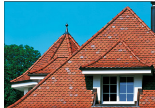
Dach pokryty klasyczną dachówką ceramiczną – karpówką
