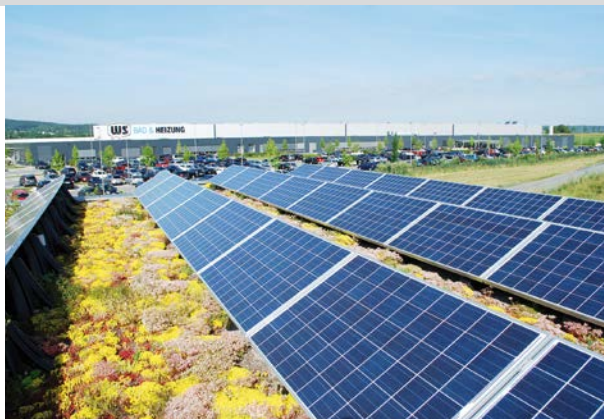
FOT. Fotowoltaika na zielonym dachu z roślinnością w uprawie ekstensywnej; fot.: Optigrüen International AG
