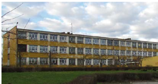
FOT. 1. Budynek szkoły w Końskich przed termomodernizacją;
