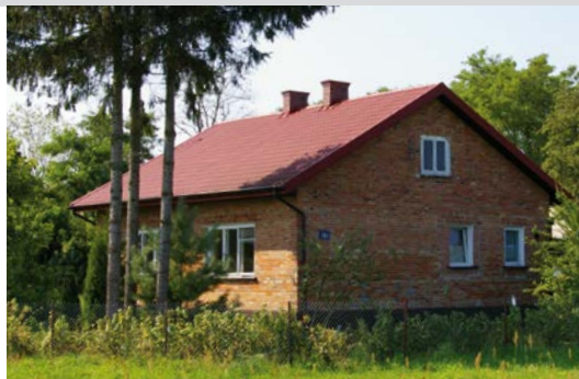
FOT. 3. Budynek jednorodzinny pod Siedlcami przed termomodernizacją; fot.: KAPE S.A.
