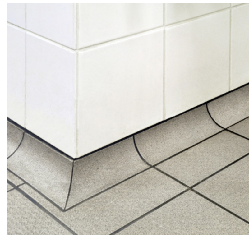
Stadion w Gdańsku – fragment posadzki w trakcie prac
