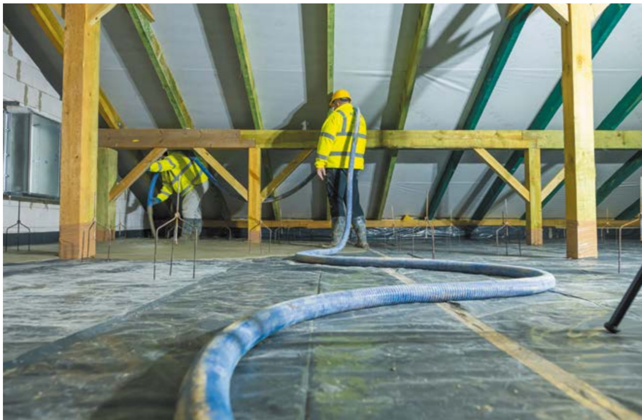
Aplikacja mineralnej piany izolacyjnej Airium na poddaszu
